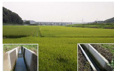
【写真】水路整備により保全をはかった水田（戸塚区）
