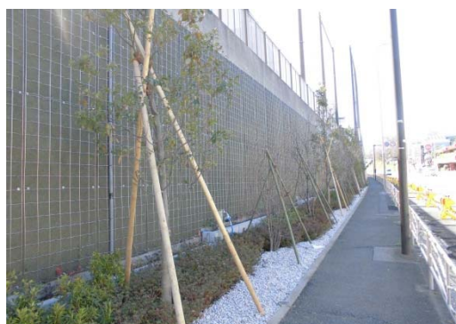
【写真】沿道緑化（鶴見区/北寺尾地区）
