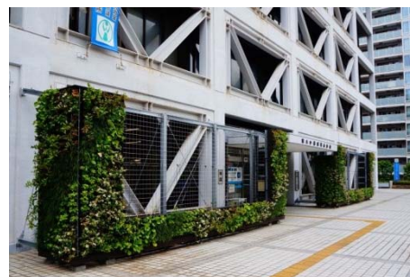
【写真】事例（保土ヶ谷区庁舎）
