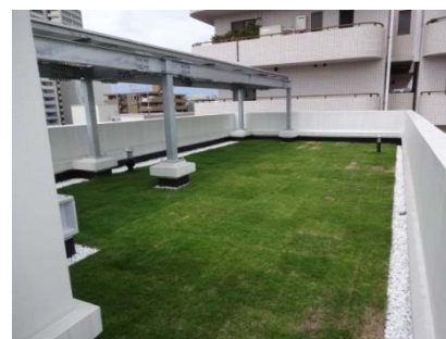
【写真】屋上緑化の事例 (西区平沼一丁目)
