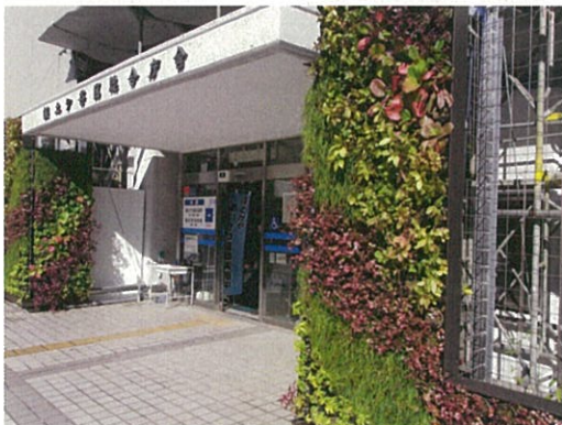
保土ヶ谷区庁舎 庁舎入口部分の壁面緑化
