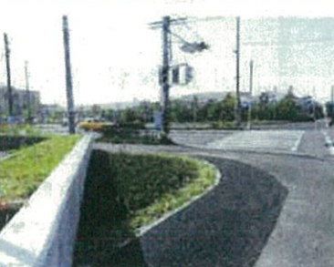
▲3月28日撮影 緑地帯整備
