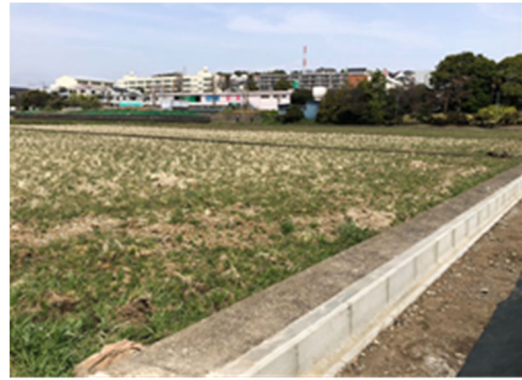
水田の用水路の更新(青葉区恩田町)
