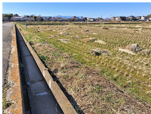
水田の用水路の修繕(泉区和泉町)
