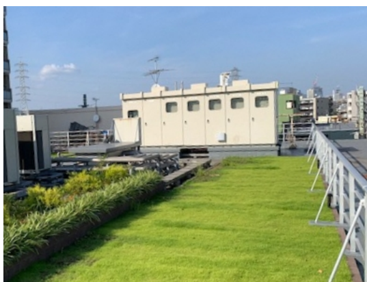
病院の屋上緑化助成(鶴見区佃野町) 【公開性のある緑空間の創出支援】
