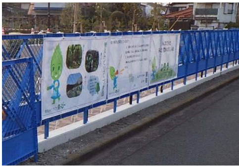
工事現場での現地表示
