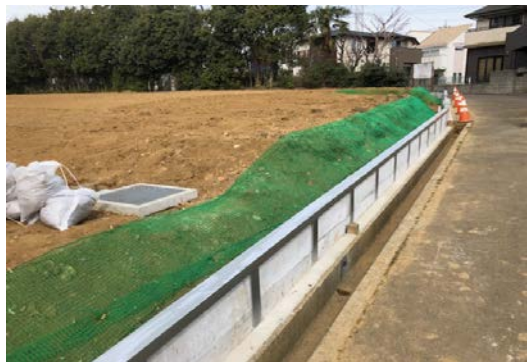
土砂流出防止対策を実施した農地 (都筑区東方町)
