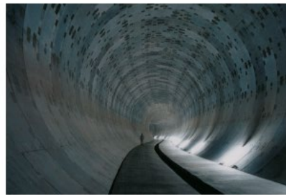
今井川地下調節池の内部（今井川：保土ヶ谷区）
