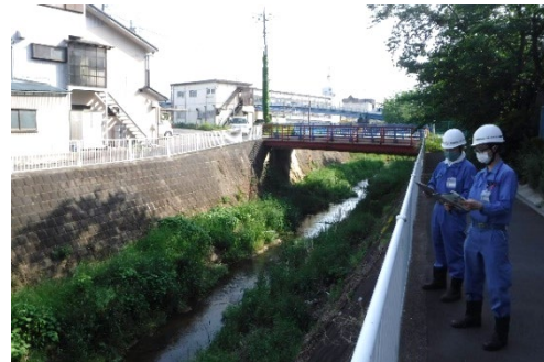
図 2-2 土砂堆積状況
