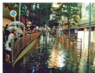
平成16年9月22号の浸水状況 (帷子川:横浜駅西口付近)
