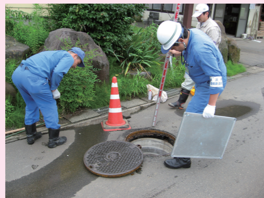
新潟県中越沖地震 調査時の様子
