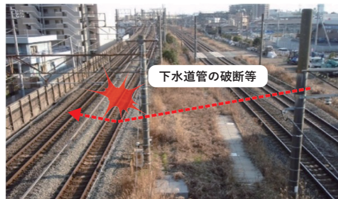
鉄道軌道下の下水道管の耐震化
