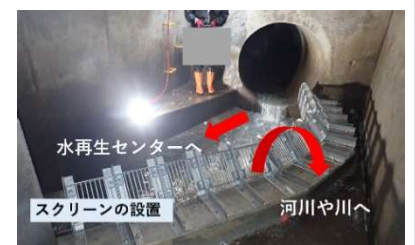
雨水吐の改良状況
