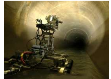
中大口径管の調査状況
