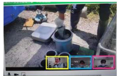
工事現場のリモート立ち会いの様子
