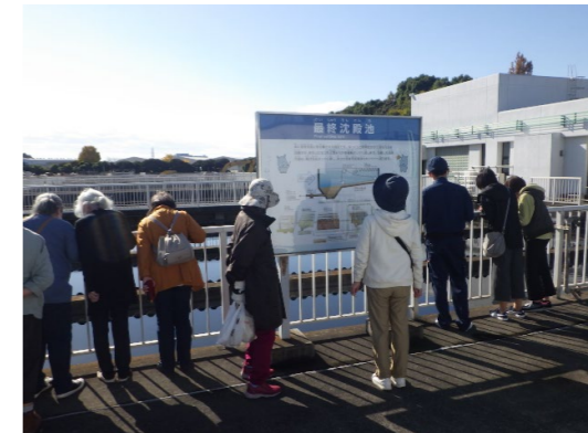
最終沈殿池の下水処理
