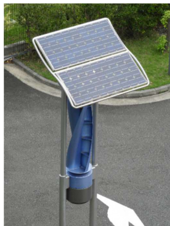
入り口付近に設置されている風力／ソーラーパネル（ハイブリッド発電設備）
