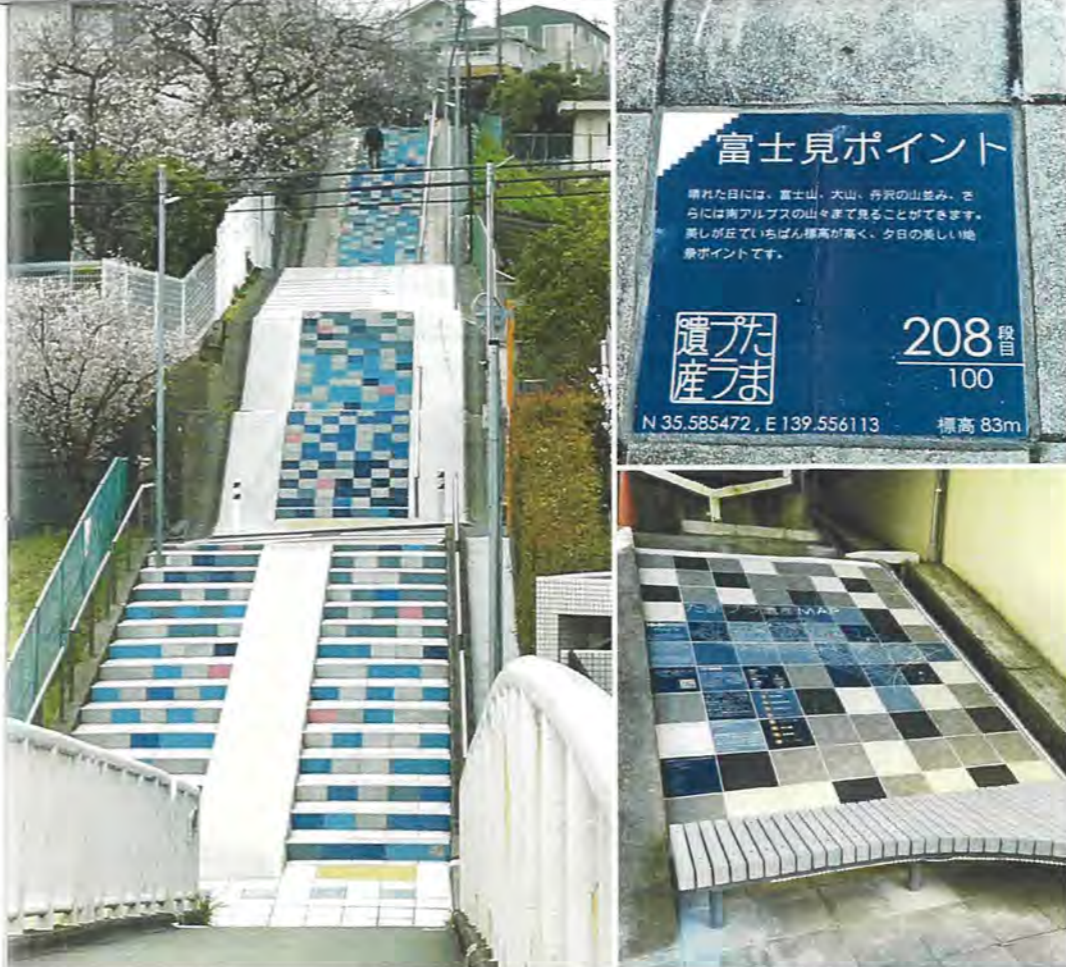
少し離れた場所からでも、カラフルな色彩で目を引く百段階段(左) 地域に点在する案内プレートには、百段階段の何段目の高さに当たるかが記載されている(右上) 情報看板前にはベンチを設置し、夜間はライトアップされる(右下)
