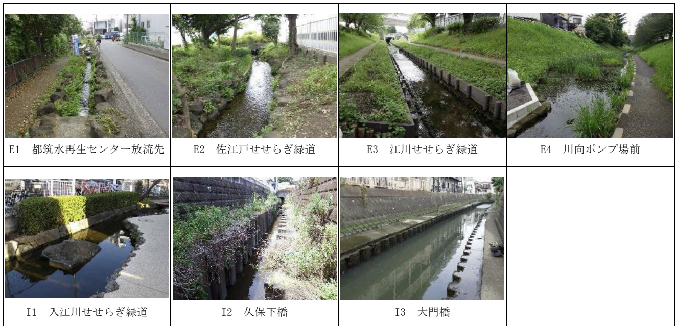
図 2 江川・入江川における調査地点の外観
