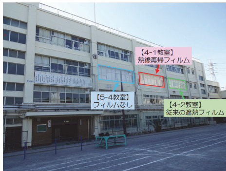
図3 調査を行った教室の外観
