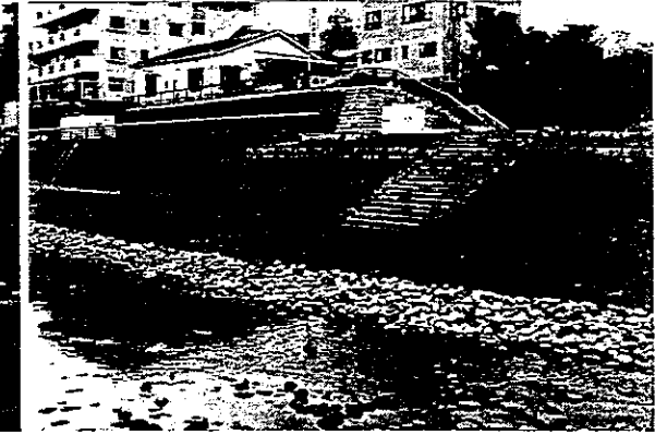
▲静水域の中間の瀬の下流には一部流れをつくった。 ▲階段部の護岸は布団籠に覆土したもの。
