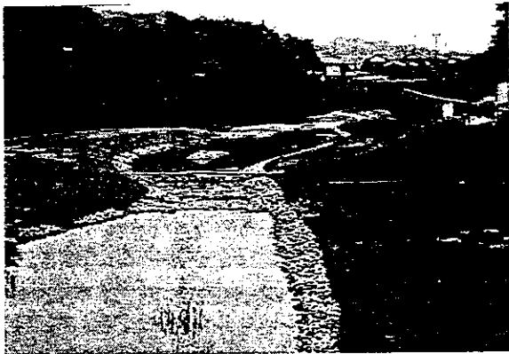
▲静水域の中間の瀬の下流には一部流れをつくった。 ▲階段部の護岸は布団籠に覆土したもの。
