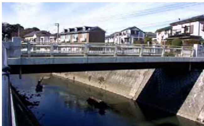
帷子川 学校橋
