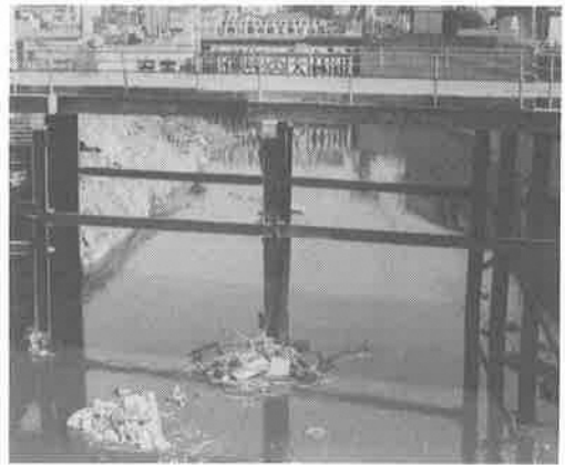
st. 16 日野川 K工場排水口
