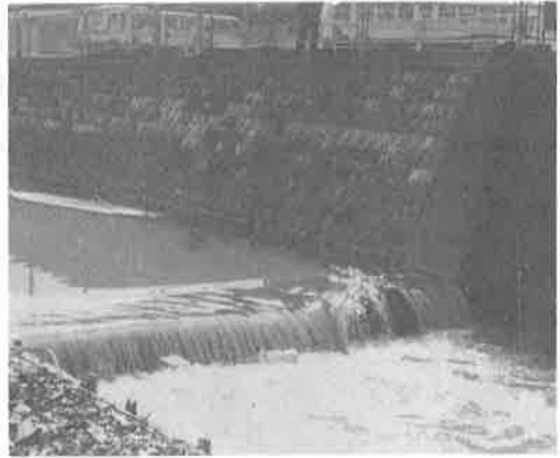
st.11 帷子川 鎧橋
