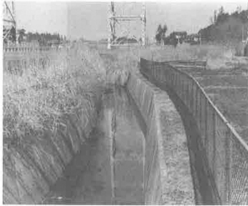
st. 12 帷子川 大貫橋上流
