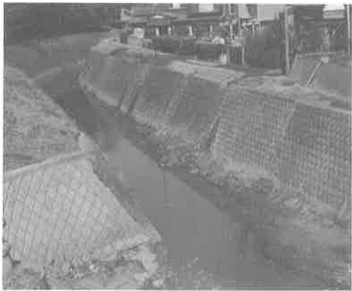
st. 14 大岡川 日下橋
