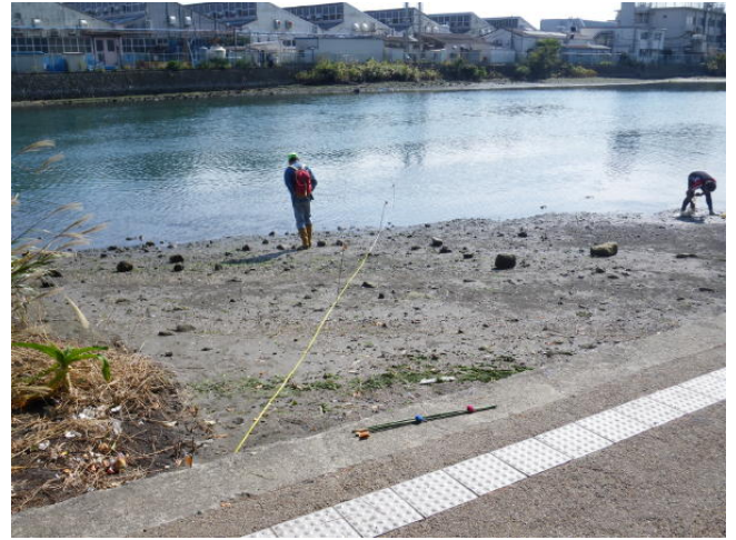
写真 3 (16) 野島水路全景
