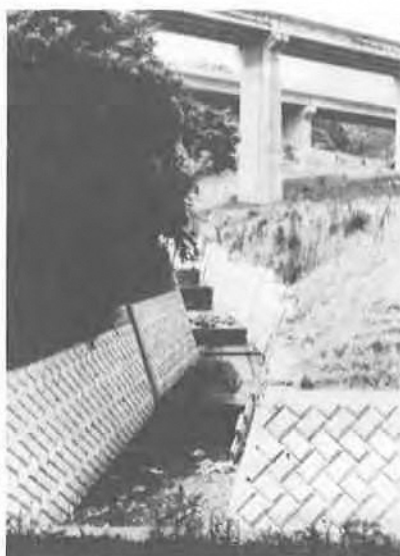
M. 南横浜バイパス下のコンクリート護岸
