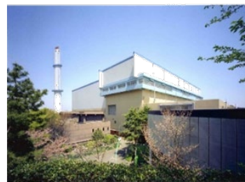
保土ヶ谷工場
