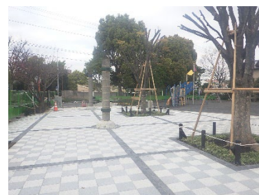
公園での透水性舗装等の整備による雨水の保水・浸透機能の向上（都筑区）
