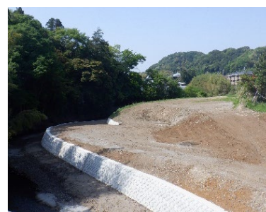
河川改修の状況（栄区）
