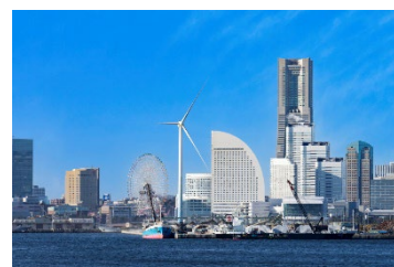
横浜市風力発電所（ハマウイング）
