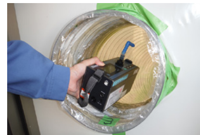
立入検査の様子 (デジタル粉じん計による確認)
