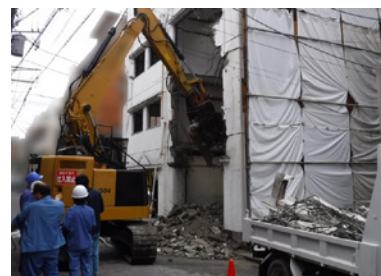
解体工事現場の調査の様子 ※写真の一部を加工しています
