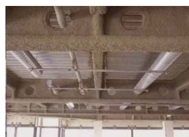
石綿の使用例（吹付け石綿）
