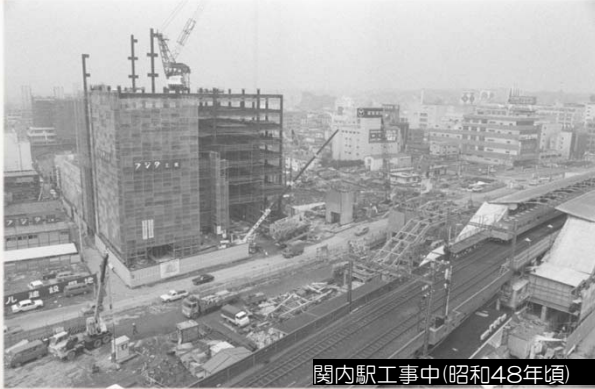
関内駅工事中(昭和48年頃)
