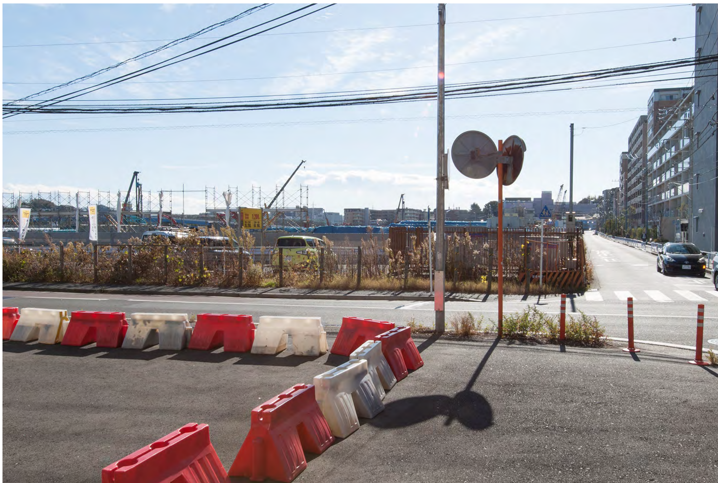
図 3.7-1(7) 建設前の状況写真（地点 15：西側敷地北西側（南方向を眺望））〈本編 p.6.11-31 の図 6.11-3(15) 拡大版(焦点距離 35mm 相当の画角)〉
