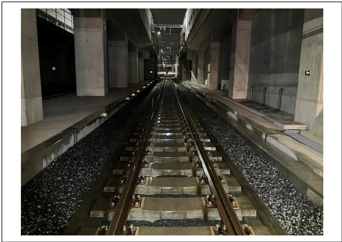
写真 2.3.1-3 環境保全のための措置の実施状況（消音バラスト）
