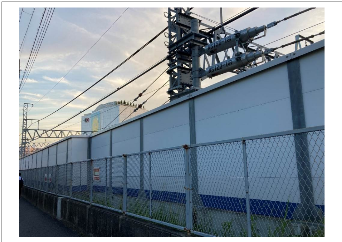
写真 2.3.1-4 環境保全のための措置の実施状況（防音壁の設置）
