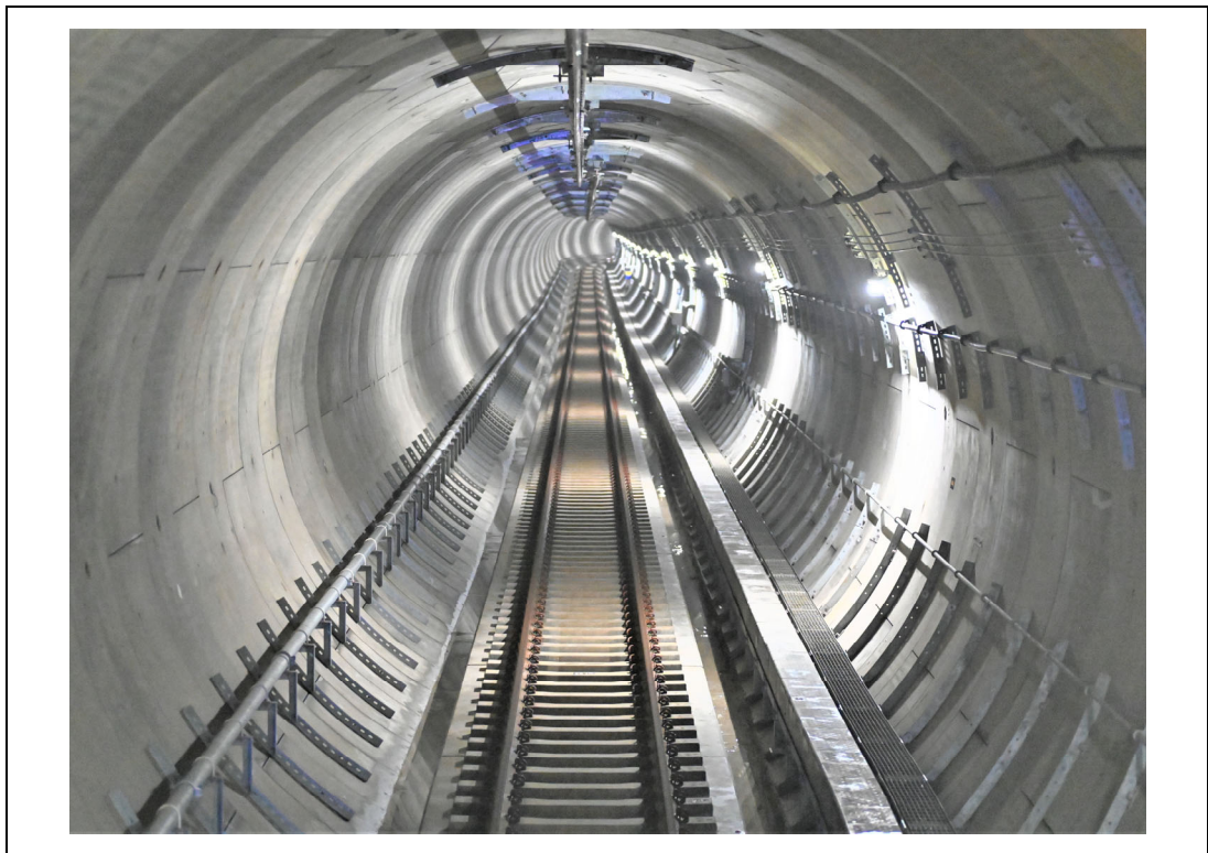
写真 2.3.1-2 環境保全のための措置の実施状況（ロングレールの敷設）
