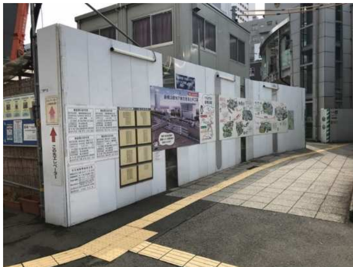
写真 2. 4. 4-1(1) 環境保全のための措置の実施状況（仮囲いの設置）
