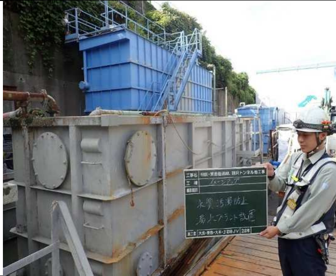
写真 2.4.4-6 環境保全のための措置の実施状況（濁水処理設備による排水処理）
