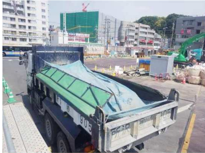
写真 2. 4. 4-3 環境保全のための措置の実施状況（工事用車両の荷台への防塵シートの敷設）
