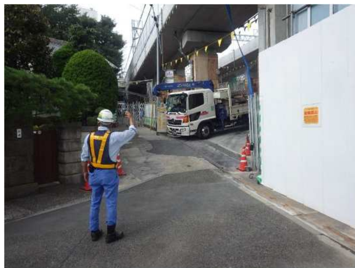
写真 2. 4. 4-9 環境保全のための措置の実施状況（通行車の誘導）
