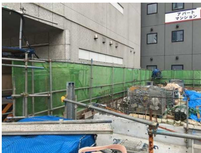
写真 2. 4. 4-1(2) 環境保全のための措置の実施状況（飛散養生シートの設置）
