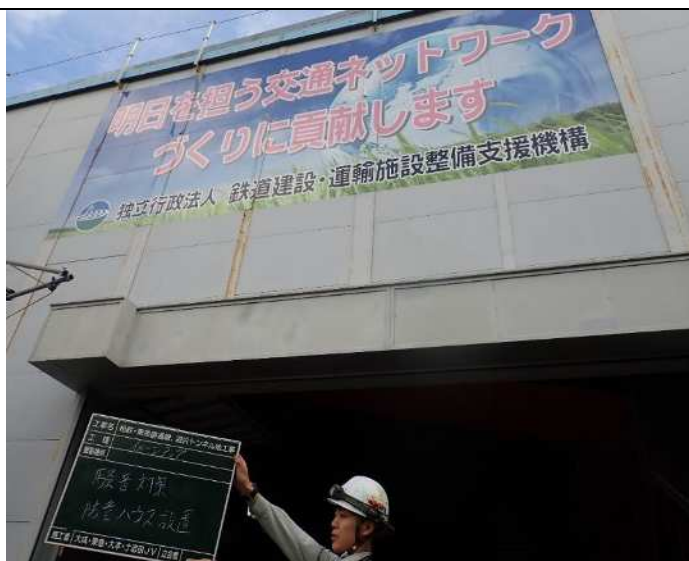
写真 2. 4. 4-1(3) 環境保全のための措置の実施状況（防音ハウスの設置）
