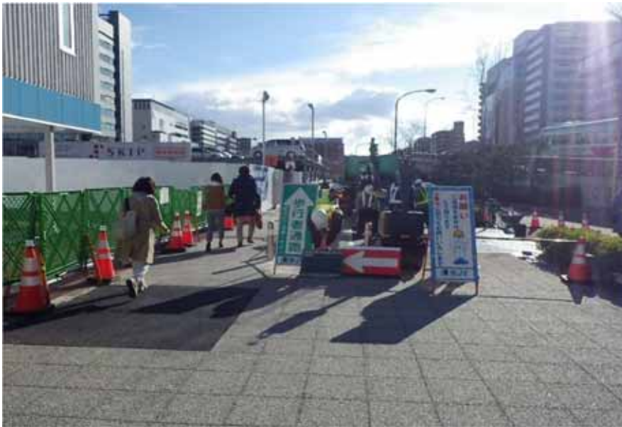
写真 2.5.4-8 環境保全のための実施状況（迂回案内（通行者の誘導））
