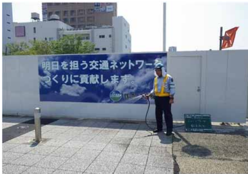
写真 2.5.4-2 環境保全のための実施状況（工事現場での散水や清掃）
