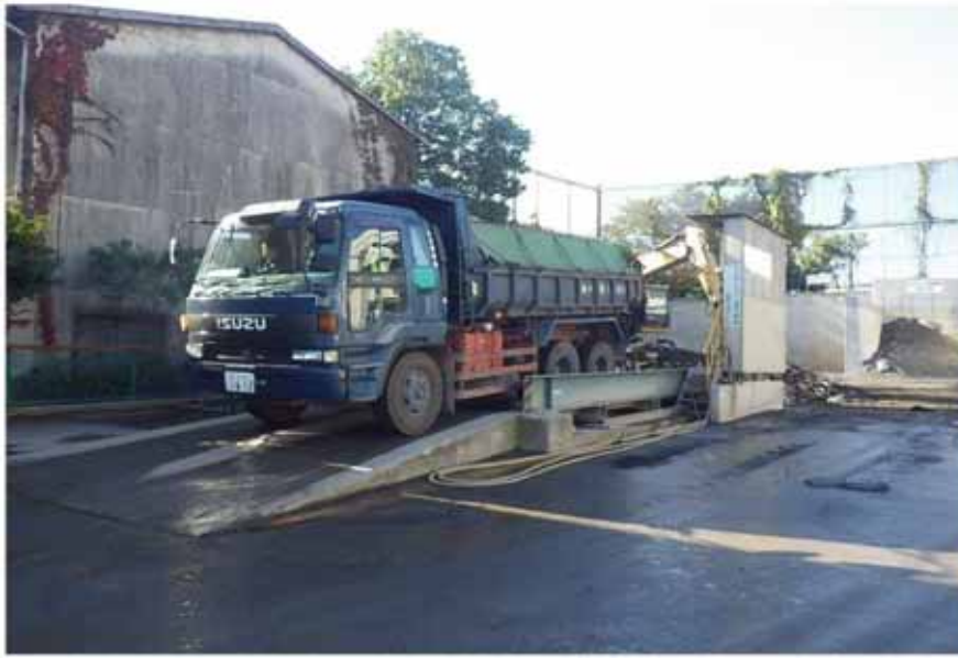
写真 2.5.4-3 環境保全のための実施状況（工事用車両の荷台への防塵シートの敷設）
