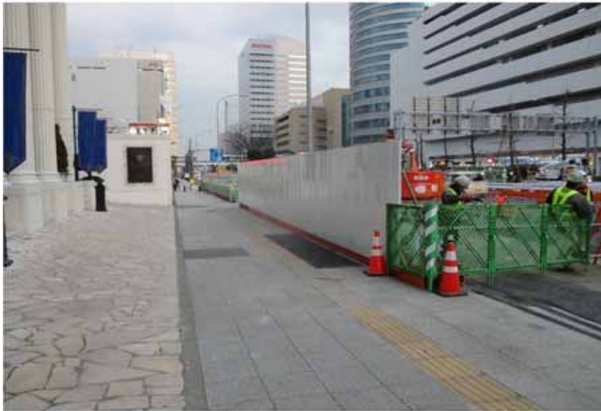
写真 2.5.4-1 環境保全のための実施状況（仮囲いの設置）
