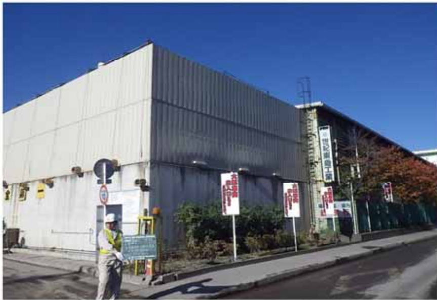
写真 2. 5. 3-2 環境保全のための実施状況（再資源化処理施設への運搬）
