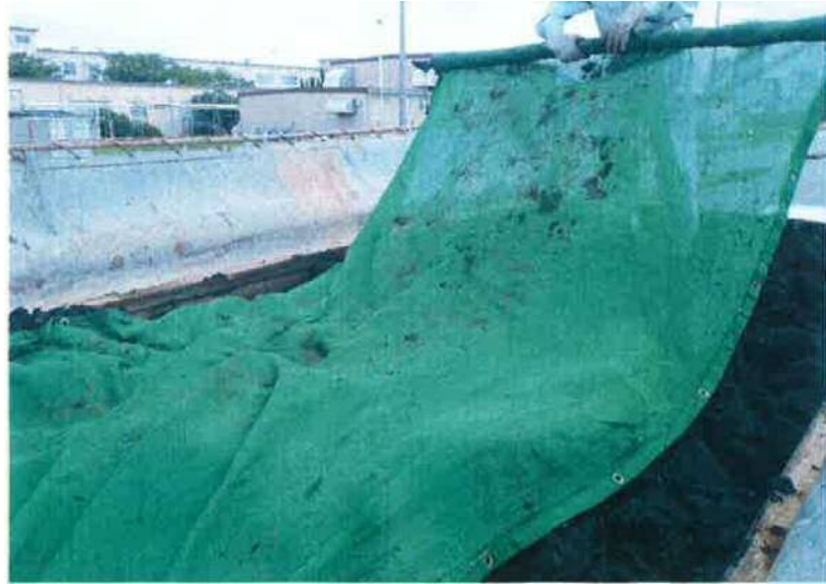
写真 4-4 環境保全のための措置の実施状況（工事用車両の荷台への防塵シートの敷設）
