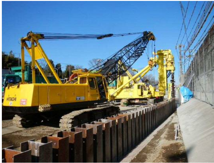
写真 3.3.4-1 環境保全のための措置の実施状況（止水性の高い連続壁の設置）
