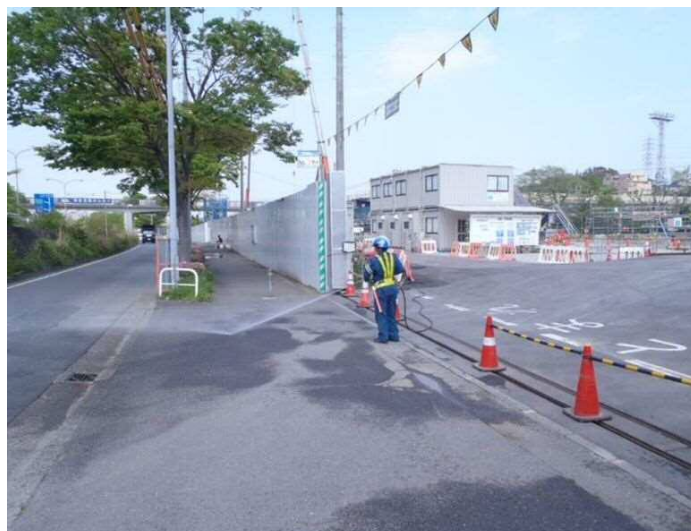
写真 4-3 環境保全のための措置の実施状況（工事現場での散水や清掃②）
