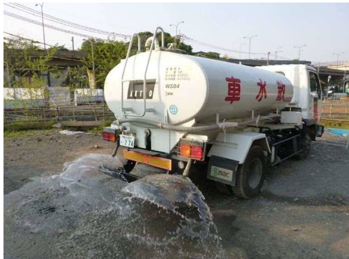
写真 4-2 環境保全のための措置の実施状況（工事現場での散水や清掃①）
