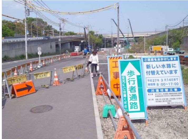
写真 4-10 環境保全のための措置の実施状況（迂回案内（通行者の誘導））
