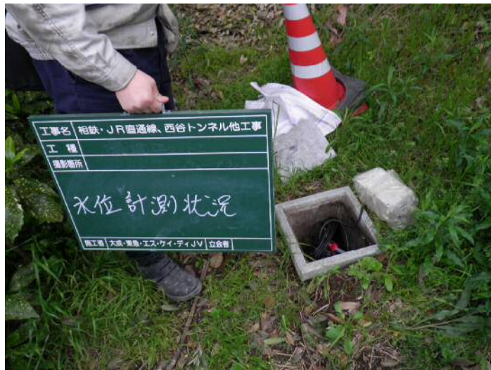
写真 3.3.4-2 環境保全のための措置の実施状況（地下水位の観測）
