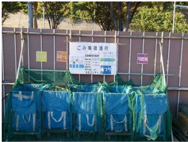
写真 3.3.5-1 環境保全のための措置の実施状況（建設廃棄物の分別処理）
