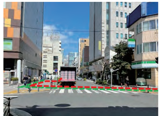
②山下町第3号線 南側より
