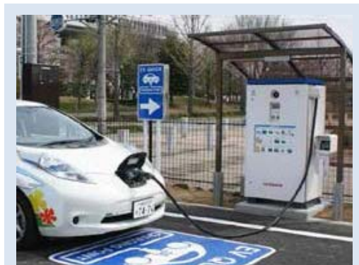
EV充電器の設置
