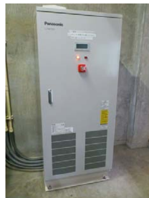
蓄電池の設置
