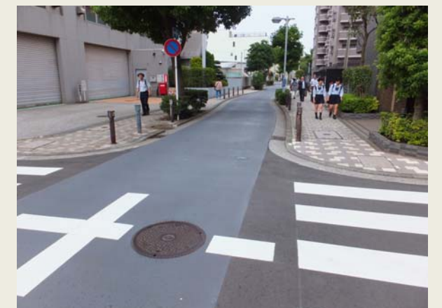
遮熱性すず風舗装
