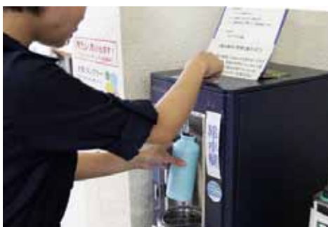
▲戸塚地区センターのマイボトル用浄水機
