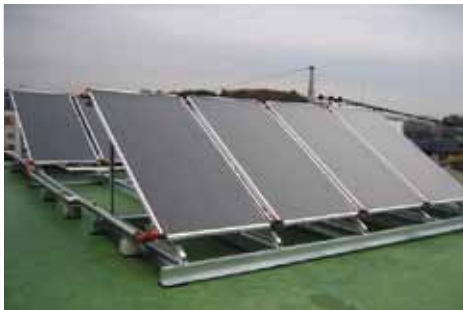
▲太陽熱給湯システム設置
