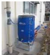
▲雨水貯留タンク
