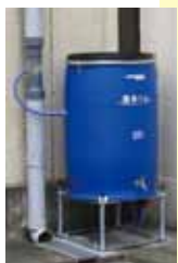
◀雨水タンク設置状況
