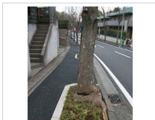
根上がり対策工事で植栽したリュウノヒゲ
