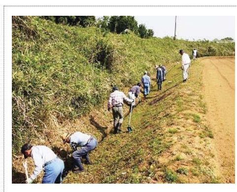
水路清掃 (瀬谷区上瀬谷)
