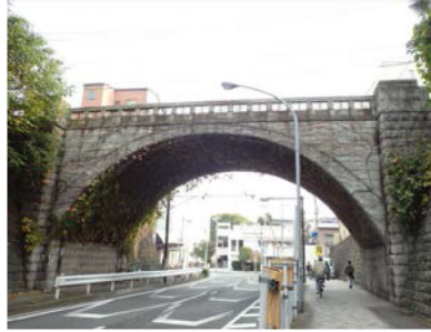
さくらみちばし 櫻道橋
