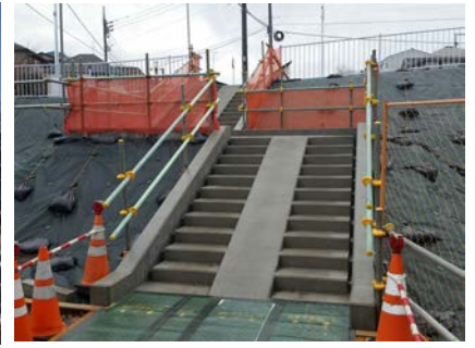
写真② 階段工事
