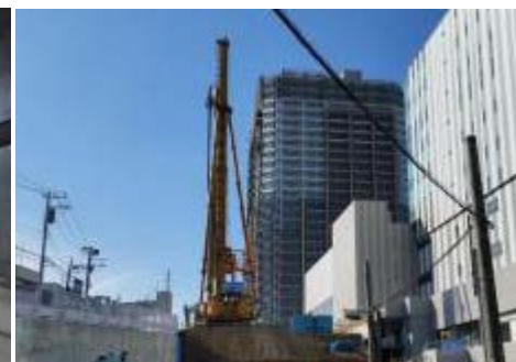
写真② 地中連続壁工
