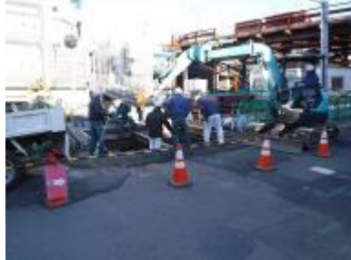
写真① 大型マンホール工事
