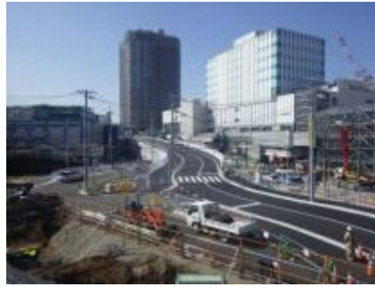
写真① 接続道路工事
