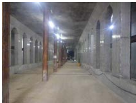
写真① 本体構造物
