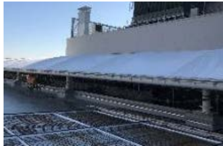
写真① 幕屋根工事
