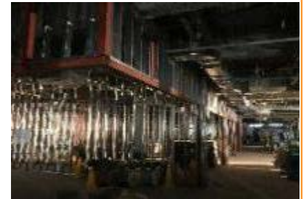
写真② 内装工事
