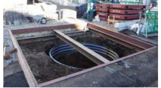
写真① 大型マンホール工事
