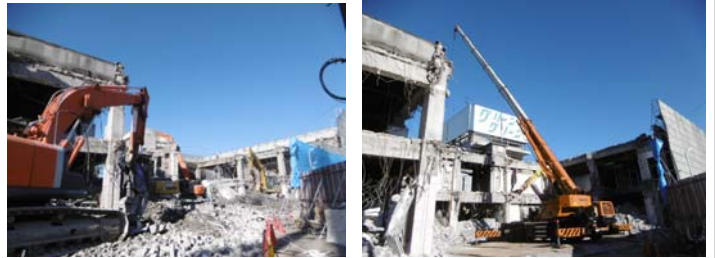
○躯体解体の様子
