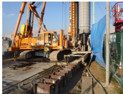
○山留工事の様子
