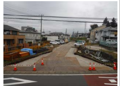
○暫定道路整備の様子
