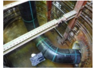
○新設管埋設状況
