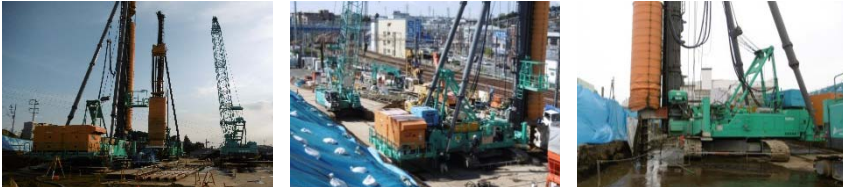
○山留壁(SMW)工事の様子
