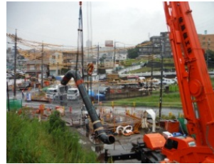
○新設管埋設の様子
