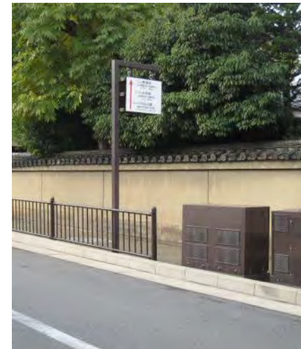
案内サイン、地上機の例（京都府京都市）
