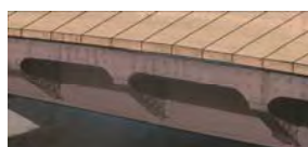
新設茶屋町橋 （橋長：約9m）
