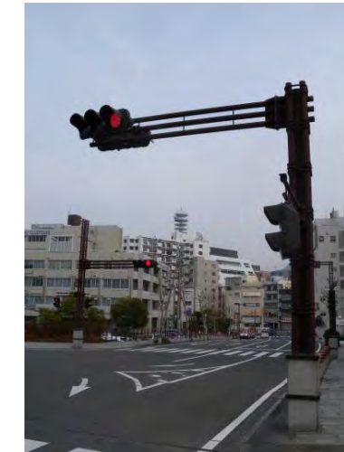
信号柱の例（長崎県長崎市）
