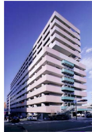
みなみ市民活動・多文化共生ラウンジ外観
