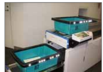
書庫から本を運ぶエレベーター
