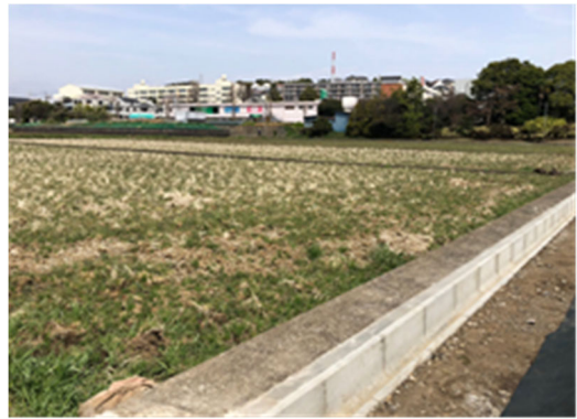
水田の用水路の更新(青葉区恩田町)
