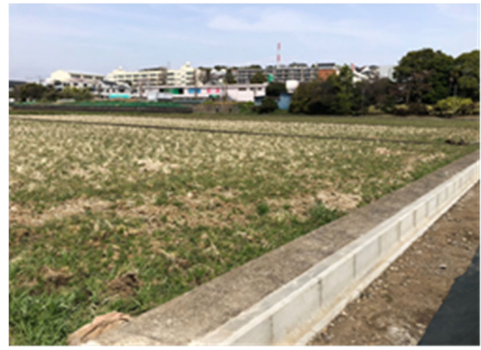
水田の用水路の更新(青葉区恩田町)
