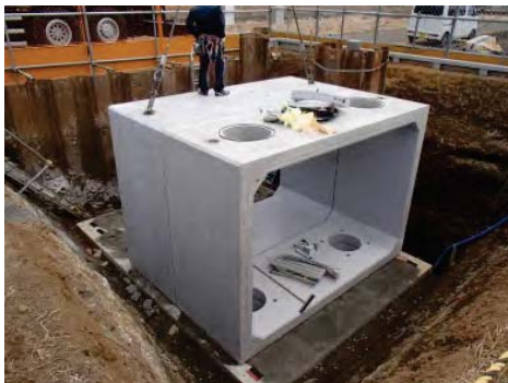
【写真】地下貯水槽の設置（緑区）
