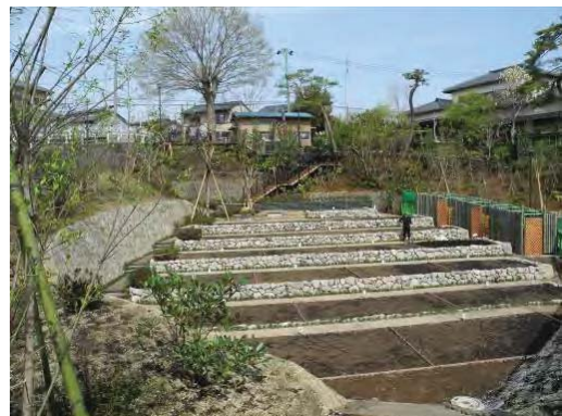
農園付公園整備事業 (旭区南本宿第三公園 (完成))
