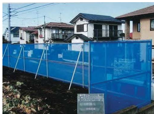
環境配慮型施設整備事業による農薬飛散防止ネット(保土ヶ谷区)
