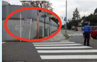
現況コンクリート擁壁
