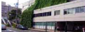
資源循環局 金沢工場
