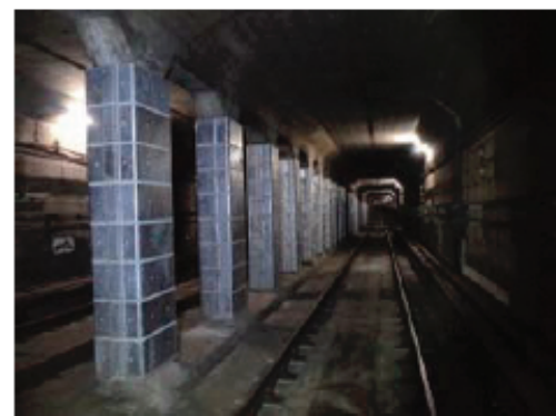
トンネル柱耐震補強
