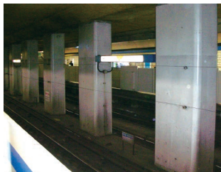
トンネル柱耐震補強▲
