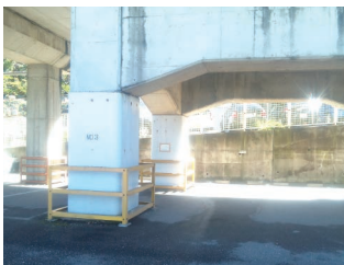
橋脚耐震補強▲
