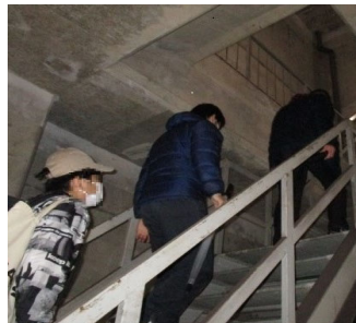
▲換気所（避難階段）
