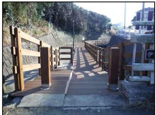
馬洗川せせらぎ緑道再整備
