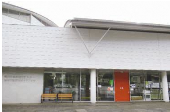
篠原地域ケアプラザ 外観 (篠原地区センターと合築)
