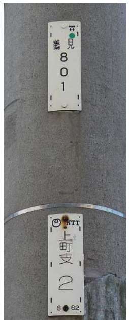
東京電力も使用しているNTT柱
